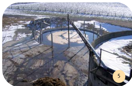
Ouvrage de stockage des déjections et effluents.
