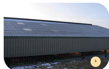
Bandeau translucide et bardage à ventelles avec sortie d'air en faîtière ouverte.
