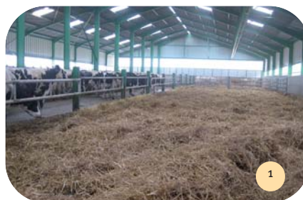
Vue intérieure du bâtiment.
