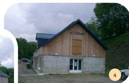
Pignon Ouest, côté salle de vente avec l'accueil des clients.
