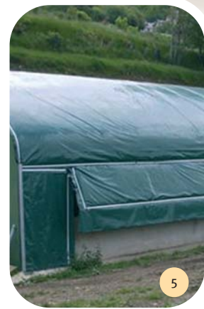
Systeme de ventilation du tunnel.
